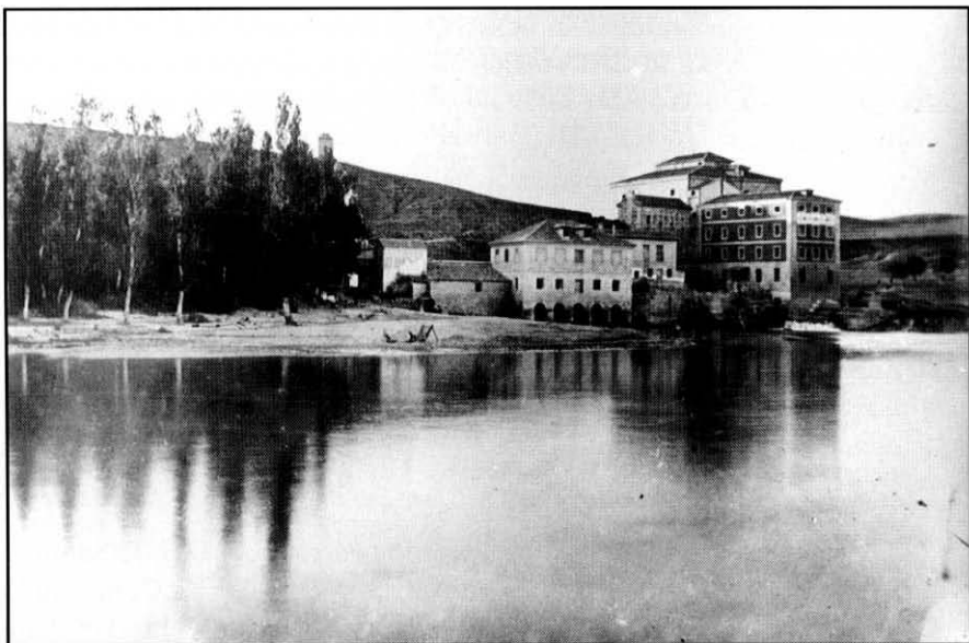
Molinos y central hidráulica de Safont, en la orilla derecha del Tajo. El más cercano, el molino harinero construido por el corregidor Navarro, con seis «molinos de Regolfo»; a su derecha, central eléctrica construida en el siglo pasado. Y aguas arriba, el azud o presa, que se conserva y utiliza en la actualidad
