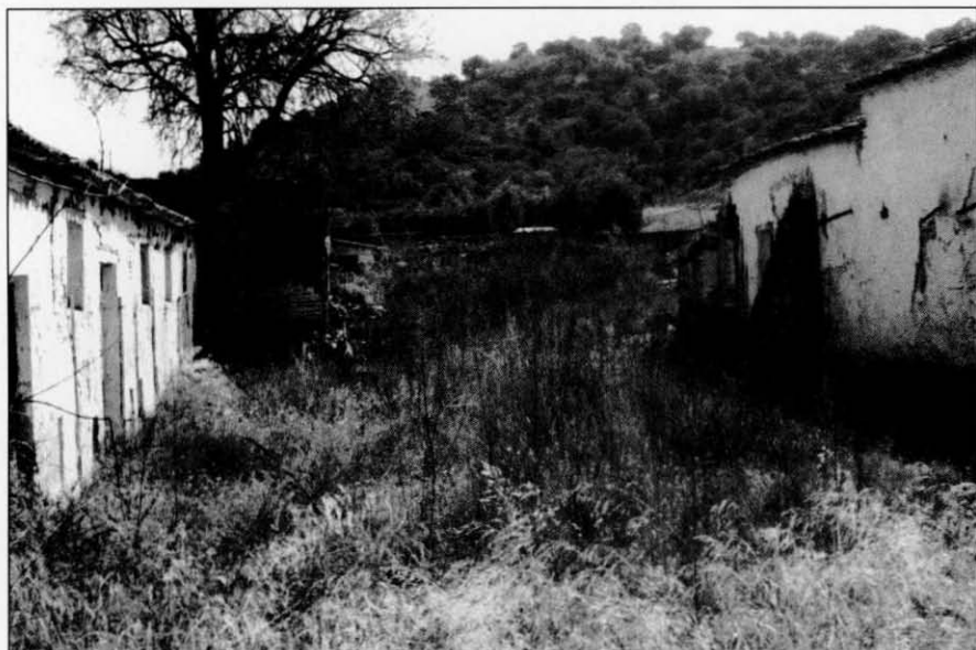
FOTO 1 Vista general de los edificios conservados en superficie
