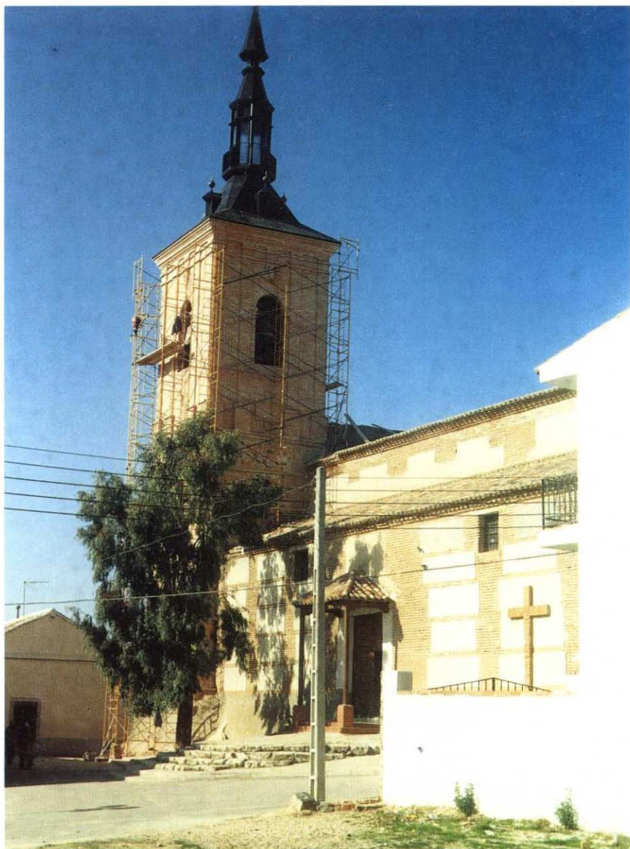
CARRANQUE: torre de campanas con el nuevo chapitel.
