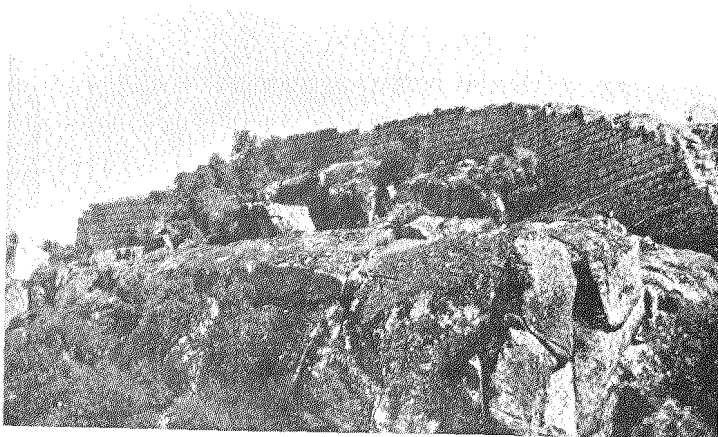
La Muralla sobre los canchos. Adviértase que no existen, en este lugar, cimientos. Puede verse el espesor del muro.
