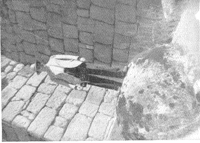
Rinconada de una de las torres que encuadran la puerta principal.
