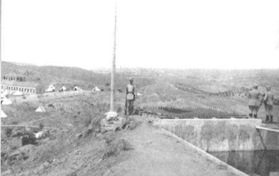
Centinela del reduto y depósito de agua (1913).
