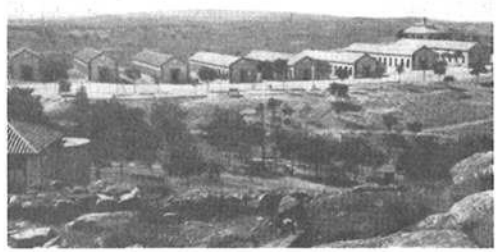
El Campamento en 1916 con sus ocho barracones ya construidos.
